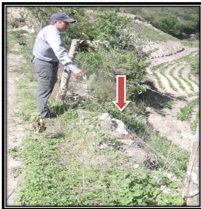
Figura 7. Vestigios rocosos desprendidos por propietarios de terrenos aledaños al tramo.
